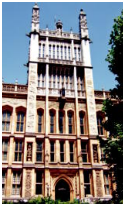
▲ Biblioteca Maughan este clădirea simbol a King's College London
